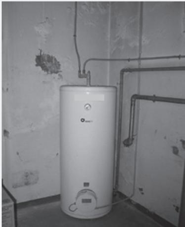
Durch ungedämmte Warmwasser- und Heizleitungen (wie auf dem folgenden Bild ersichtlich, aufgenommen im Keller eines Einfamilienhauses im Seeland) geht viel Wärme verloren. Die Kosten für das nachträgliche Wärmedämmen sind sehr rasch amortisiert.
