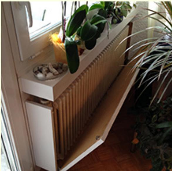
Im Bild oben ist der Heizkörper fast vollständig eingepackt und kann so die Wärme kaum in den Wohnraum abstrahlen. Warme Luft muss ungehindert in den Räumen zirkulieren können. Daher sollten die Heizkörper weder mit Möbeln noch mit Vorhängen verdeckt werden.
